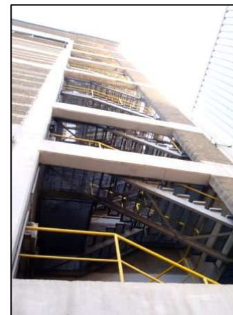
vnější schodiště otevřené
