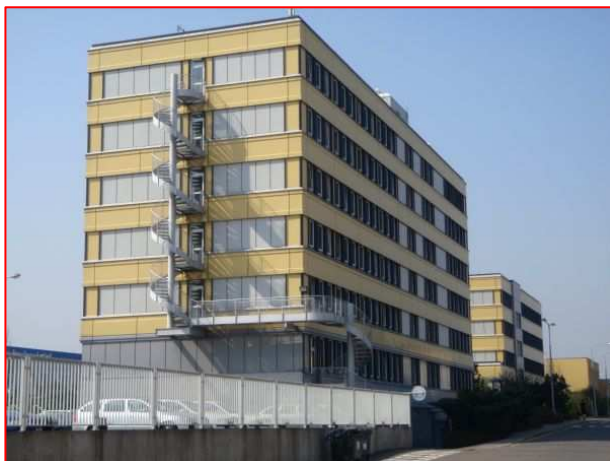
vnější schodiště bez ochrany
