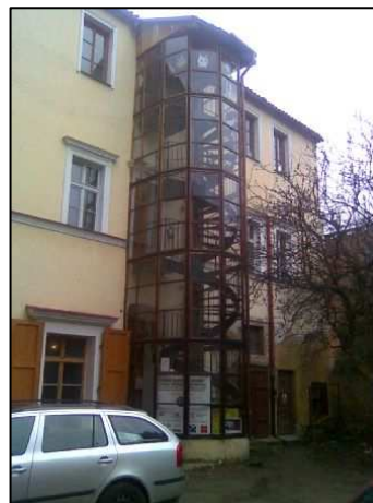
vnější schodiště uzavřené
