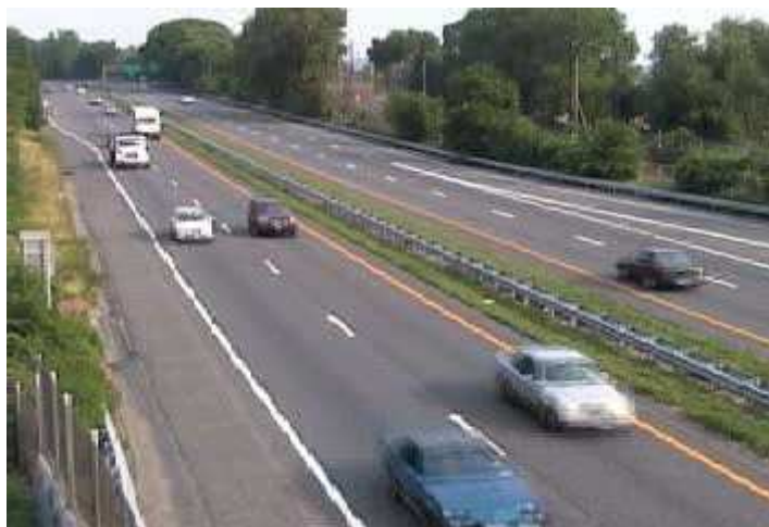
Prostý CCTV pohled
