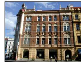
obytná budova s provozovnou
